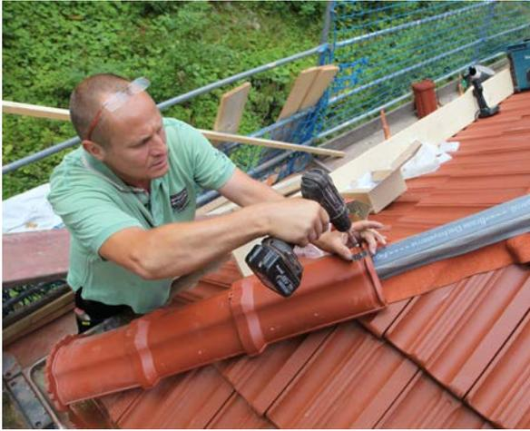
First- und Gratrollen schützen die Dachkonstruktion vor Schnee und Treibregen, hier werden gerade die Gratziegel verschraubt
