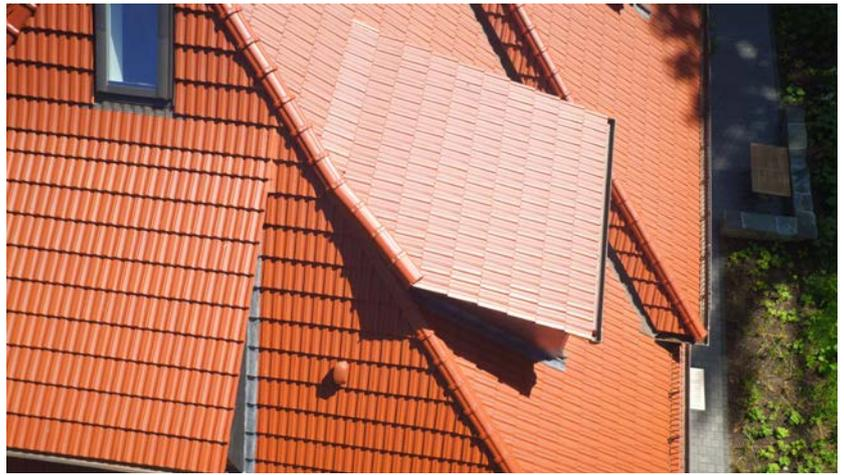
Triebregen und Flugschnee und unterstützen die Langlebigkeit der Dachkonstruktion. Der Vliesseitenstreifen ermöglicht die Anformung an das Profil der Dachziegel. So wird die Unterkonstruktion vor dem Eintrieb von Flugschnee und Treibregen in der trockenen Verlegung geschützt.
