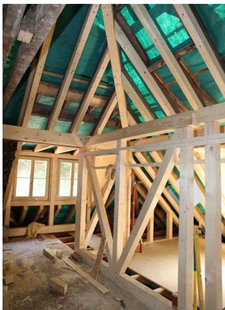
Zelte für bis zu 300 Personen aufzustellen. Vor der Wiedereröffnung mussten allerdings umfangreiche Sanierungs- und Umbauarbeiten durchgeführt werden, auch am Dachtragwerk. So waren einige Streben und Sparren des Kehlbalkentragwerks durch eingedrungene Feuchtigkeit geschädigt. Auch wurden in der Vergangenheit unfachmännisch ausgeführte Umbaumaßnahmen durchgeführt, die in die Statik eingegriffen und zu Setzungen im Dachgeschossbereich geführt hatten.
